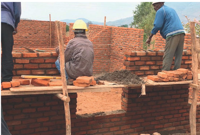
Baustelle in Ntonda
